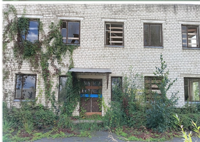
Комплекс объектов (здание школы, инв.№ 222/С-38466, здание мастерских, инв.№ 222/С-38527), Поставский район, Камайский с/с, д. Мягуны, ул. Советская, 4А.
