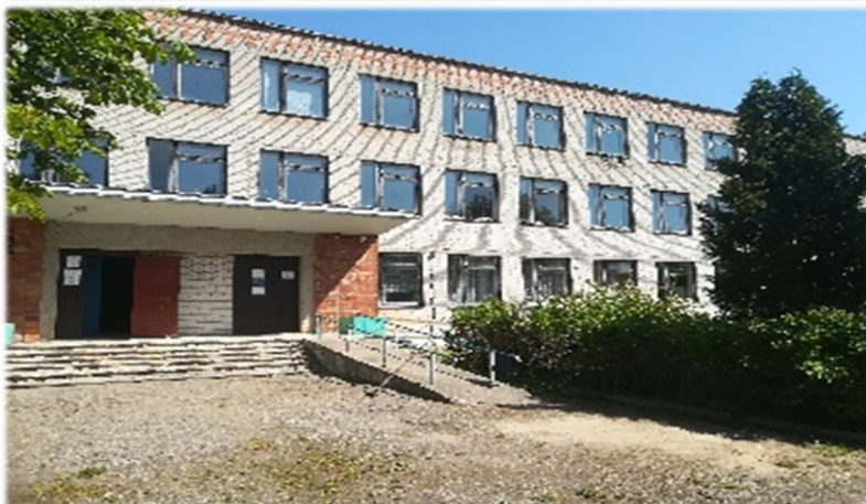
Здание школы ГУО «Клюковская детский сад – базовая школа Оршанского района», инв. № 240/С-39260 Высоковский с/с, д. Клюковка, ул. Витебская, 40 Коммунальное унитарное консалтинговое предприятие «Оршанский региональный центр поддержки предпринимательства и недвижимости» Здание площадью 3954,1 кв.м.
