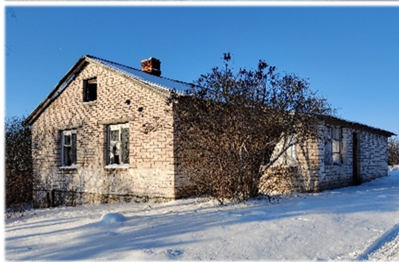
Здание Горбатицкого фельдшерско-акушерского пункта, 234/С -7826 Ушачский район, Веркудский с/с, д. Горбатица, УЗ «Ушачская ЦРБ» Одноэтажное кирпичное здание, общей площадью 52,0 кв.м., фундамент - железобетонный, перегородки-кирпичные, кровля - шиферная; полы – дощатые, отопление – печное.
