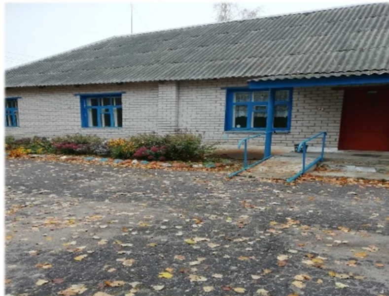
Здание Дубровской врачебной амбулатории Ушачский район, Веркудский с/с, д. Дубровка, ул. Центральная, 51А УЗ «Ушачская ЦРБ» Одноэтажное кирпичное здание, общей площадью 402,0 кв.м., фундамент - железобетонный, перегородки-кирпичные, кровля - шиферная; полы – дощатые, отопление – печное.
