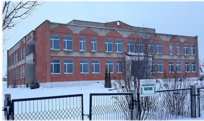
Комплекс капитальных строений Веркудской школы 234/С-9087 234/С-9219
