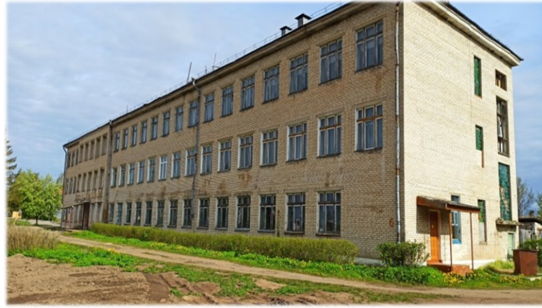
Здание школы, 251/С-72251.
