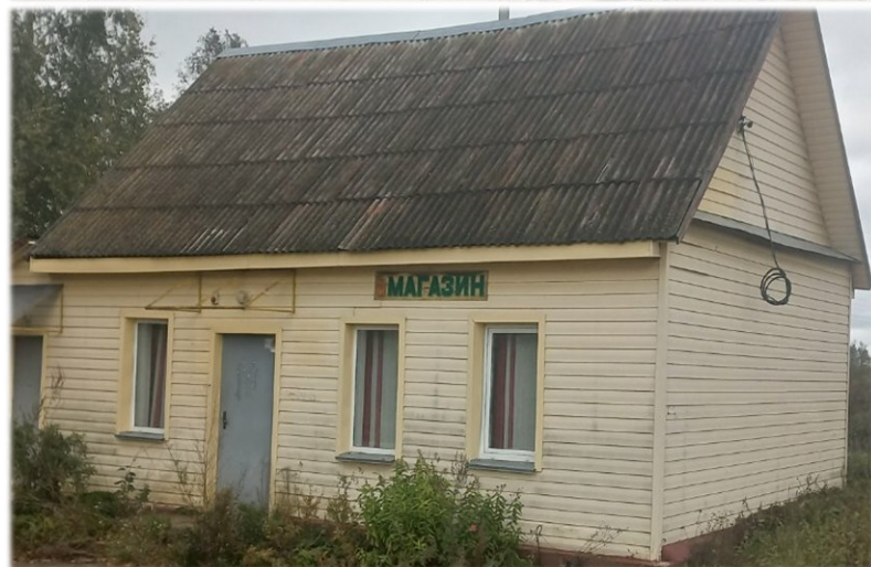
Здание магазина, инв.номер 200/С-504584. Яновичский с/с, д. Задетуни, ул. Центральная, 25А. Яновичский сельский исполнительный комитет. Одноэтажное здание 1958 года постройки, площадью 69,6 кв.м. Отопление печное. Водопровод, канализация и электроснабжение отсутствуют.
