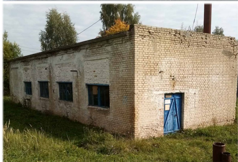
Здание котельной, инв. № 222/С-54566
