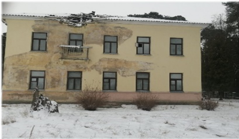
Комплекс строений ГУО «Средняя школа № 15 г. Барани» (школа, овощехранилище), инв. №№ 240/С-33211, 240/С-129595 Оршанский р-н, г. Барань, ул. Парковая, 3, 3/1, Управление по образованию Оршанского районного исполнительного комитета Здания площадью 1040,7 кв.м
