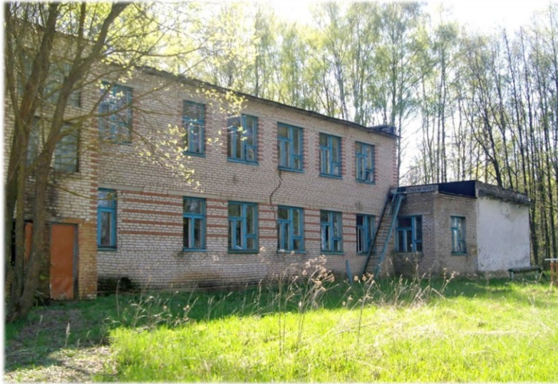
Здание базовой общеобразовательной школы 241/С-6251
