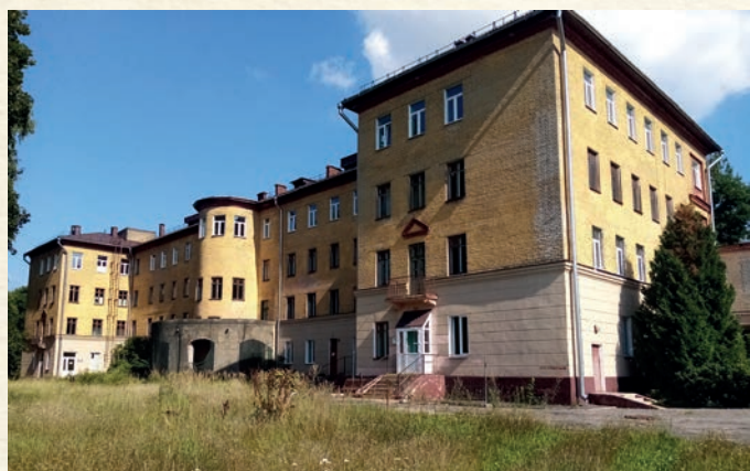
Объекты бывшей инфекционной больницы в г. Могилеве
